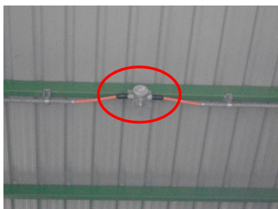
ภาพที่ 2-37 Heat Detector
