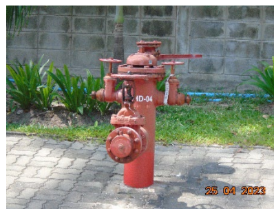
ภาพที่ 2-38 ระบบหัวชนิดดับเพลิงแบบ 2 ทาง
