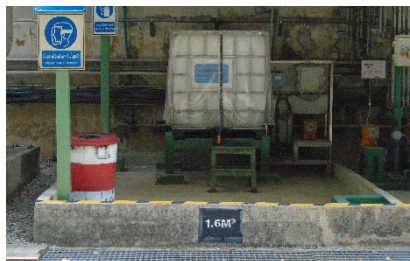
ภาพที่ 2-57 Bund Wall บริเวณที่เก็บสารเคมี
