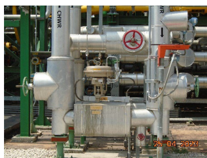
ภาพที่ 2-4 Control Valves
