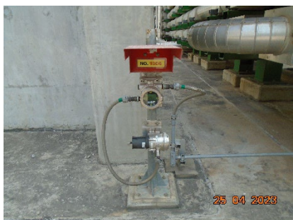
ภาพที่ 2-5 Gas Detector
