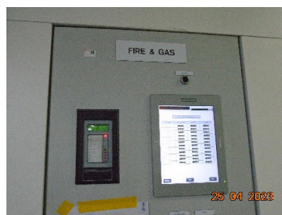
ภาพที่ 2-36 Fire Alarm และแผงควบคุมระบบ Fire Alarm
