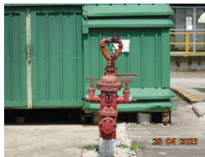
ภาพที่ 2-34 Three-Way Valve (Fixed Monitor)
