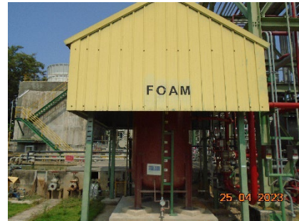
ภาพที่ 2-48 Foam Bladder Tank
