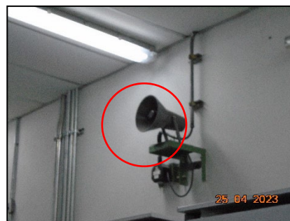
ภาพที่ 2-56 สัญญาณเตือน Siren
